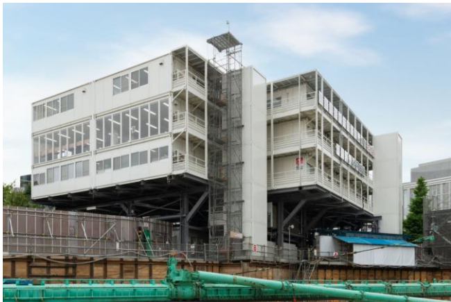
建設現場事務所
