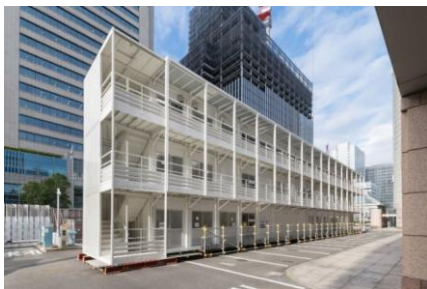
建設現場事務所
