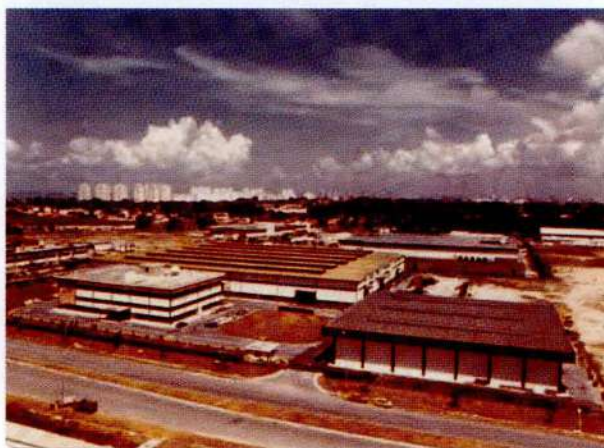
（1970 年頃 フジテック Bedok 工場の様子:写真提供 Fujitec Singapore）
