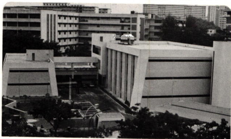
JSTC 全景 管理棟（左） と実習棟（右）
