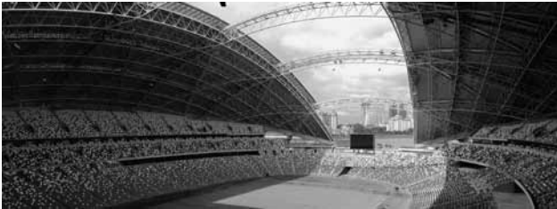
図8 屋根開口時のスタジアム内観
